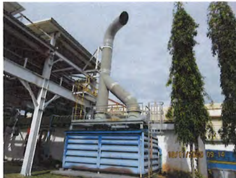
ภาพที่ 2.2-2 ระบบ Polypropylene Filter
