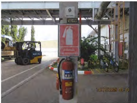
ภาพที่ 2.2-50 อุปกรณ์ดับเพลิงภายนอกอาคาร
