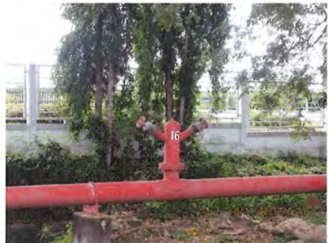
ภาพที่ 2.2-50 อุปกรณ์ดับเพลิงภายนอกอาคาร
