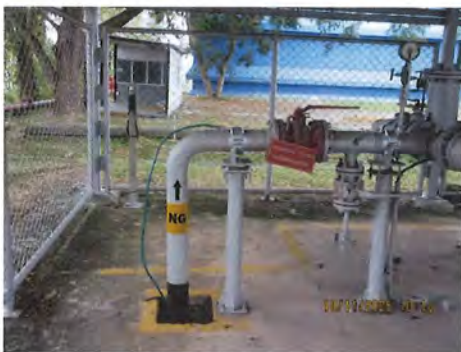
ภาพที่ 2.2-53 ข้อความแสดงทิศทางการหมุนวาล์วและข้อความแสดงทิศทางการไหลในท่อขนส่งก๊าซธรรมชาติ
